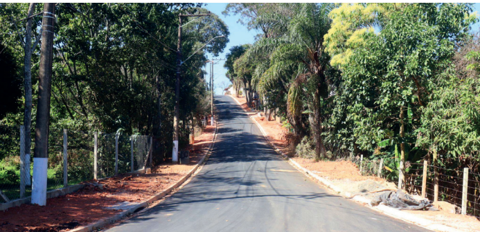
Pavimentação vem acompanhada de sistema de drenagem e melhorias estruturais para o bairro | Prefeitura de Serra Negra
