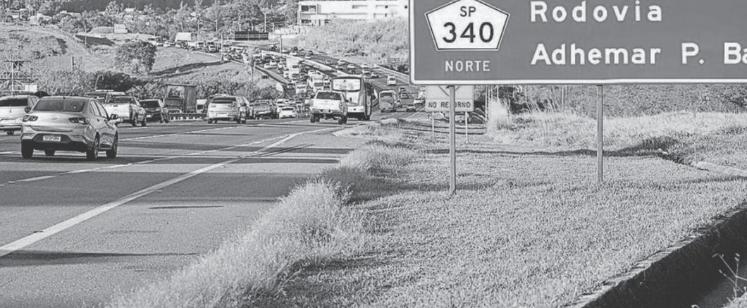
Corredor Mogi-Campinas é uma das principais rodovias da região e conecta Campinas ao Circuito das Águas | Renovias / Divulgação
