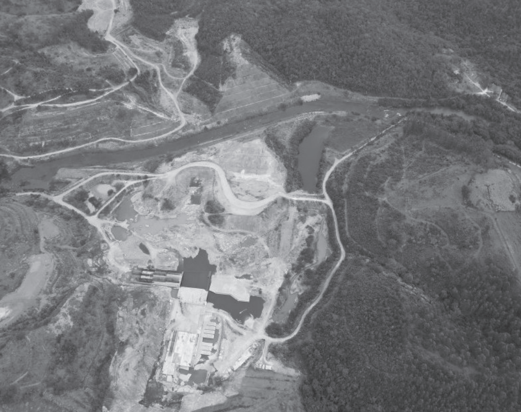
Construção das barragens de Pedreira e Duas Pontes geram polêmicas e ações judiciais | Governo de SP
