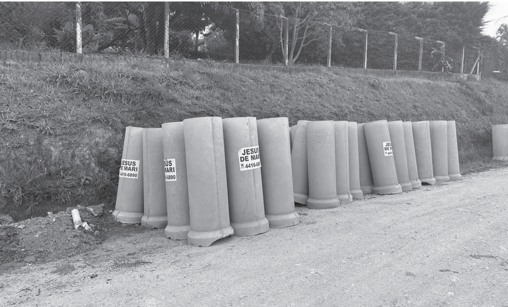
Mais de 770 metros de tubos serão instalados ao longo das vias para auxiliar no escoamento de águas pluviais | Prefeitura de Serra Negra
