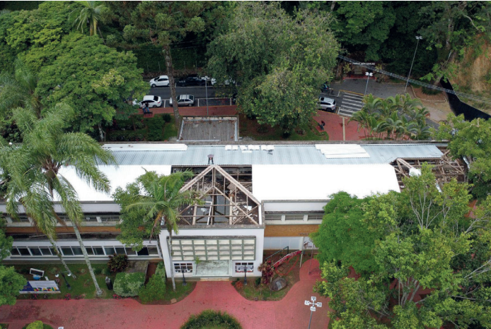
Palácio das Águas recebe obras de manutenção e preservação | PMSN
