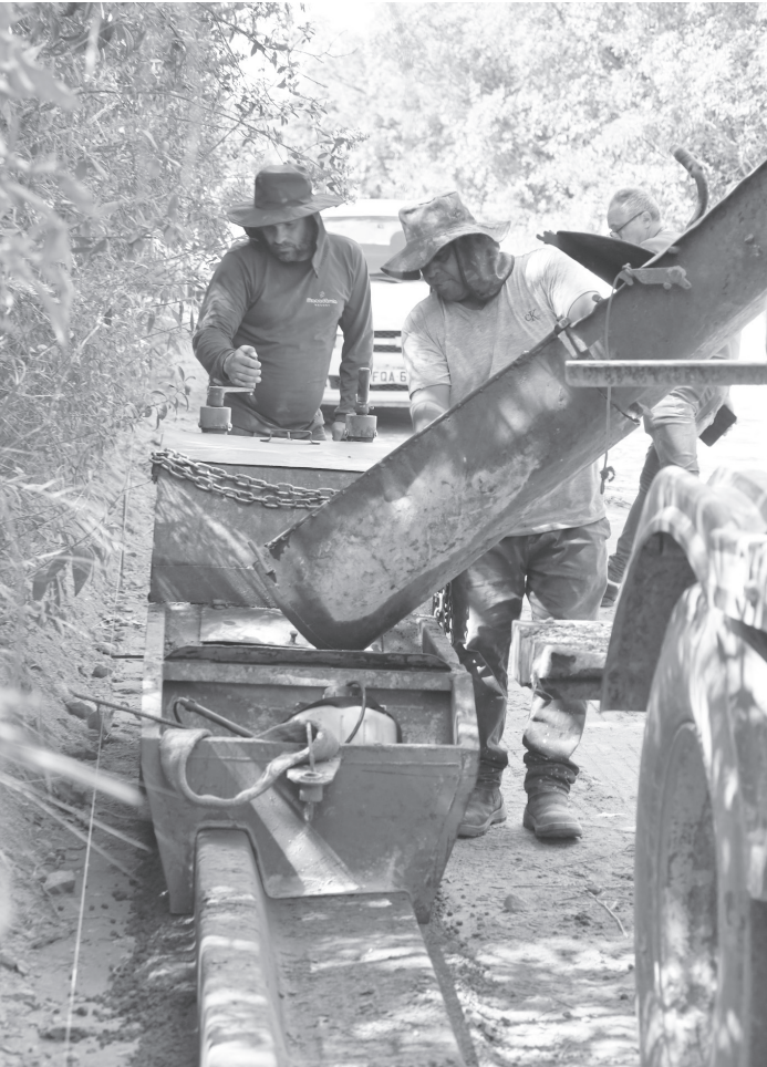
Guias e sarjetas foram instaladas no local na última semana | Prefeitura de Serra Negra
