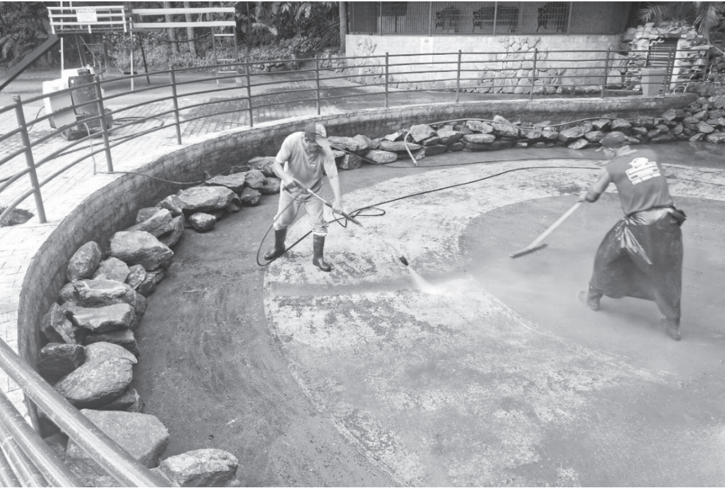
Limpeza e reparos na estrutura de alvenaria foram realizados na última semana | Prefeitura de Serra Negra
