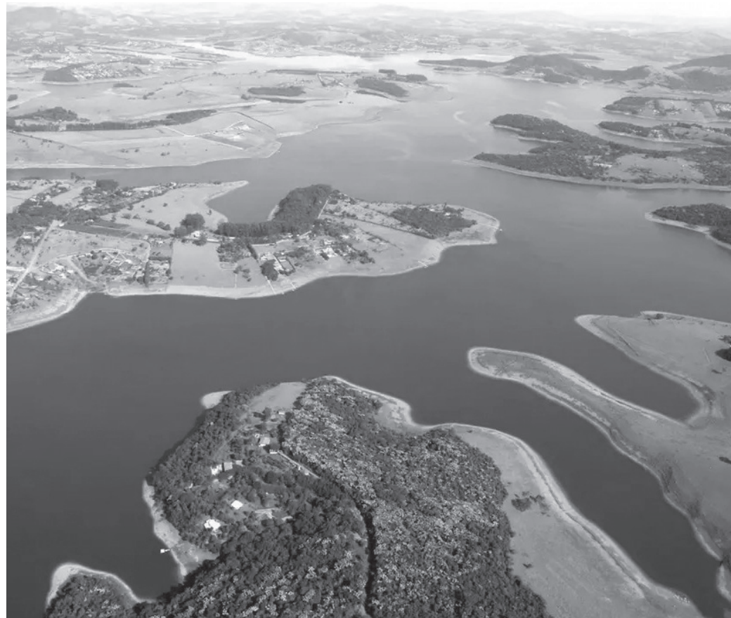
Sistema Cantareira abastece a Região Metropolitana de São Paulo e as Bacias PCJ | Secretaria de Meio Ambiente, Infraestrutura e Logística de SP
