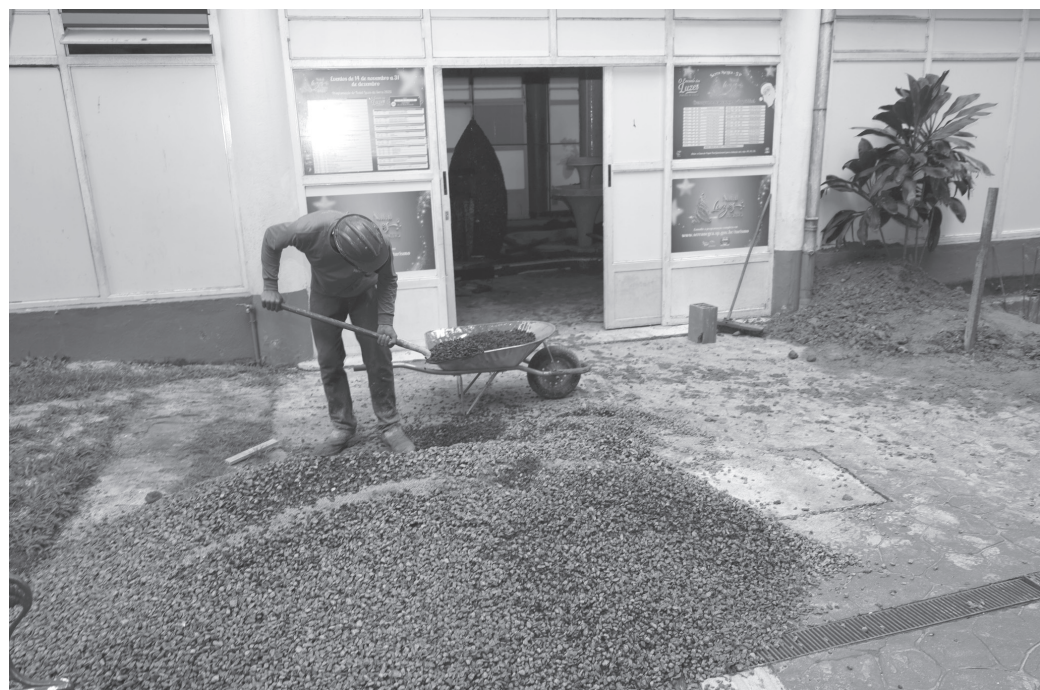
Empresa responsável pelo projeto realiza serviços de alvenaria no prédio | Prefeitura de Serra Negra
