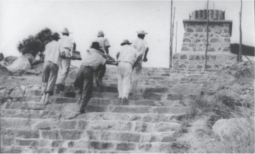
Fotografia de época retrata os operários responsáveis pela construção do Cristo Redentor | Acervo
