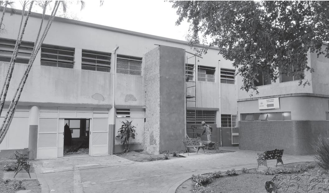
A reforma do Palácio das Águas contempla melhorias estruturais e de acessibilidade para transformar o imóvel em um novo espaço voltado ao turismo, à cultura e aos serviços públicos | PMSN
