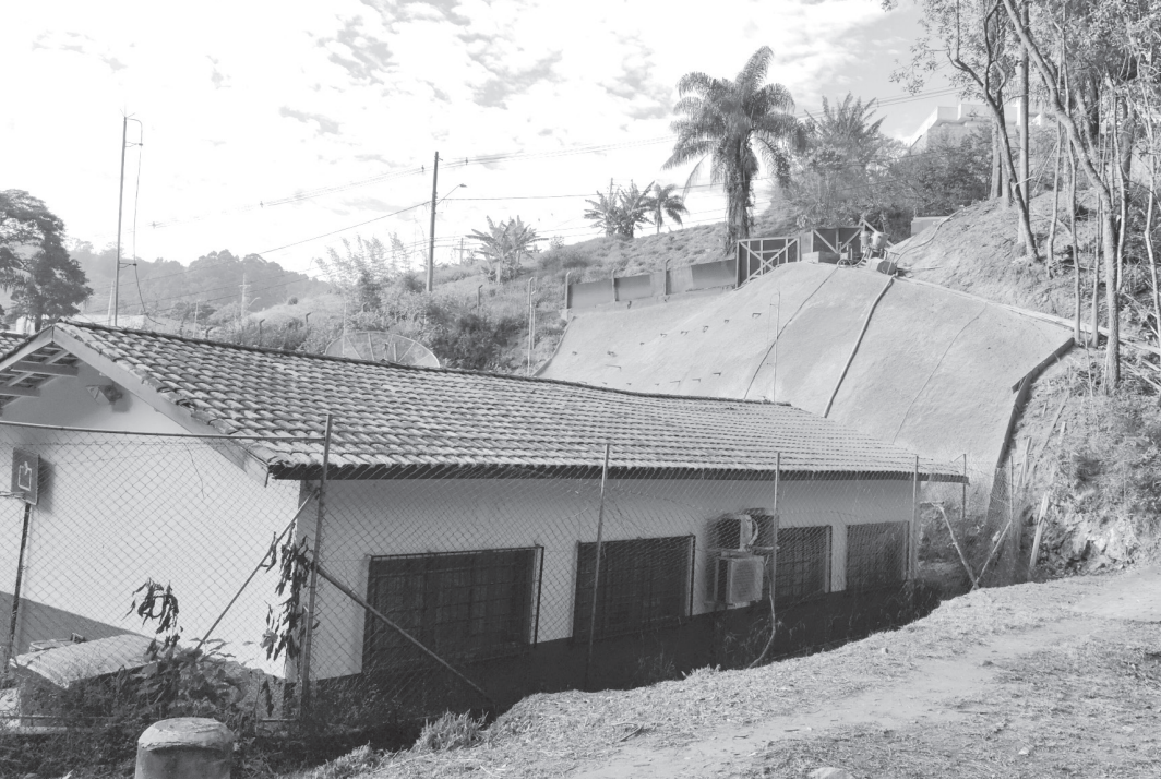
Serviços de contenção do talude seguem em andamento na escola estadual, com implantação de tirantes e reforço estrutural do terreno | PMSN
