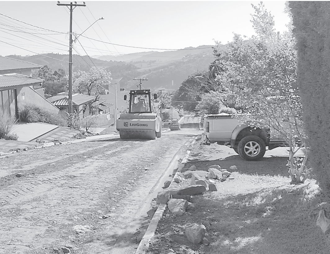
Equipes trabalham na execução da base da Rua das Primaveras, etapa que antecede a aplicação da pavimentação asfáltica | PMSN
