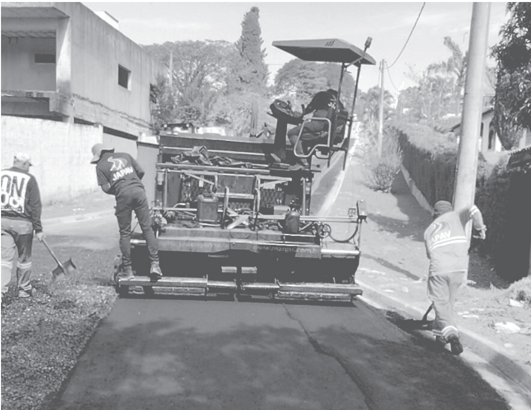
Ruas foram preparadas para receber o pavimento asfáltico | Prefeitura de Serra Negra
