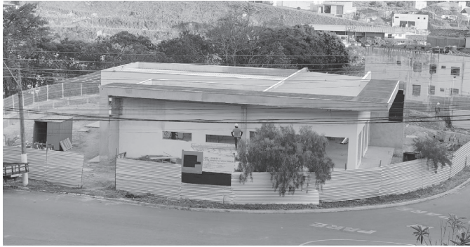
Novo prédio de 500 m² substitui antiga unidade, quatro vezes menor | Prefeitura de Serra Negra
