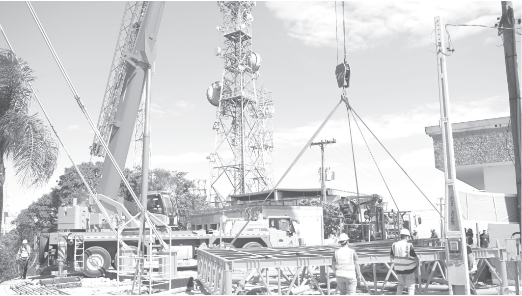
Mirante de Observação no Alto da Serra está a 1310 metros de altitude em relação ao nível do mar | Prefeitura de Serra Negra
