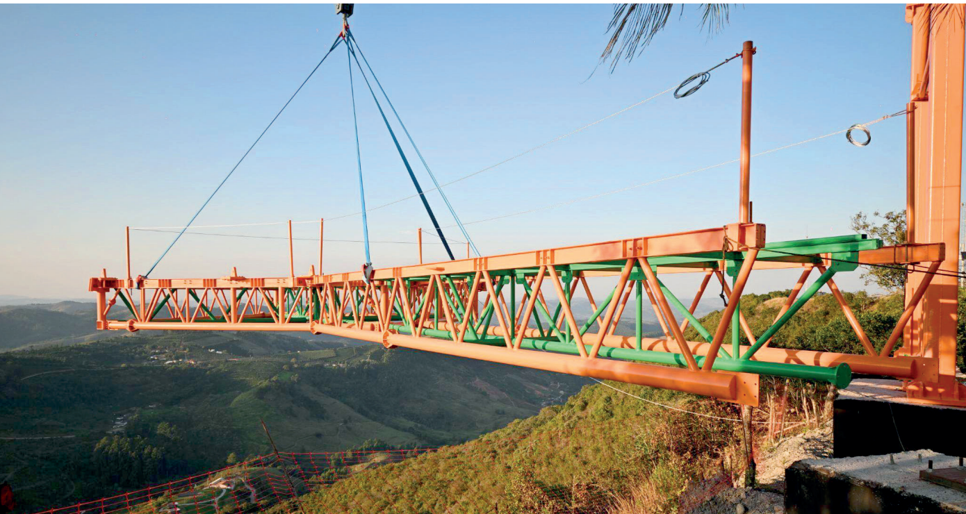
Estrutura principal do futuro Mirante do Alto da Serra é içada durante uma das etapas mais importantes das obras do novo atrativo turístico de Serra Negra | PMSN
