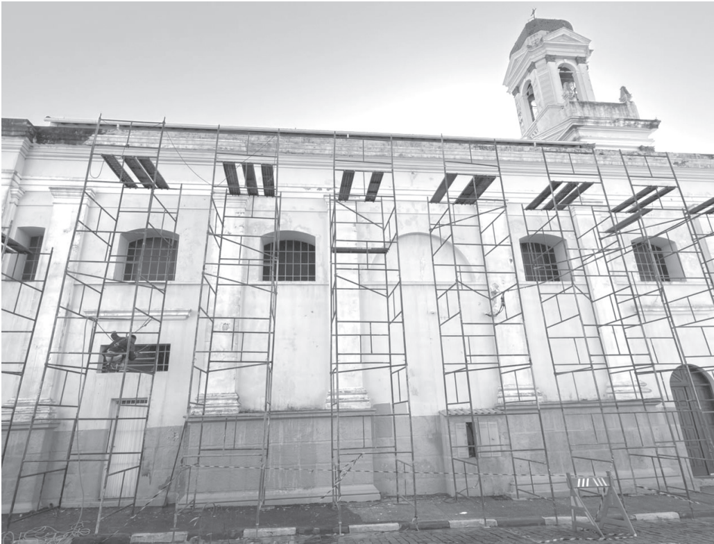
Obra prevê restauração da fachada, nova iluminação frontal e deve durar cerca de 40 dias, podendo se estender conforme as condições climáticas | Divulgação
