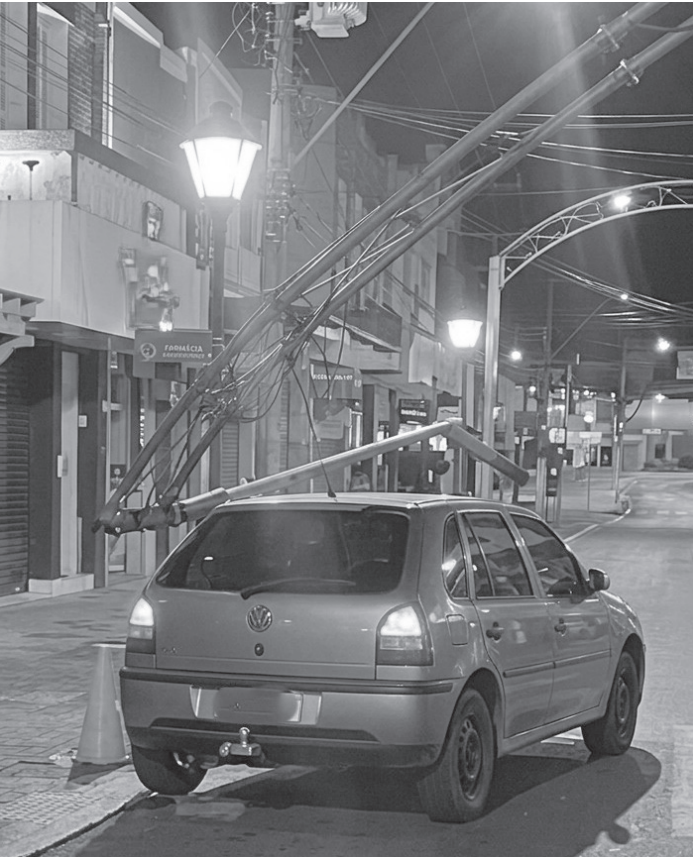
Veículo destruiu um dos arcos da Rua Coronel Pedro Penteado, no Centro | Prefeitura de Serra Negra
